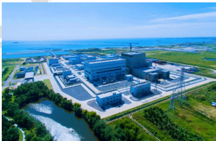
Reattore HTGR, provincia dello Shandong, Cina
