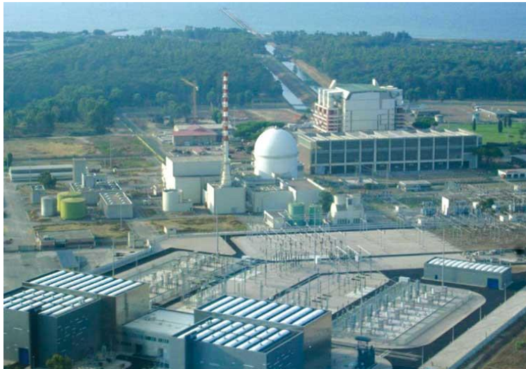
Centrale nucleare MAGNOX di Latina, Italia
